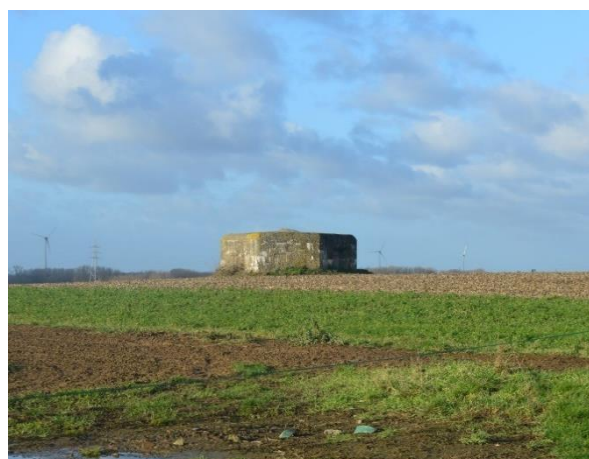
BUNKER NI8, ROOSDAAL (FOTO: THOMAS D'HOOGER)
