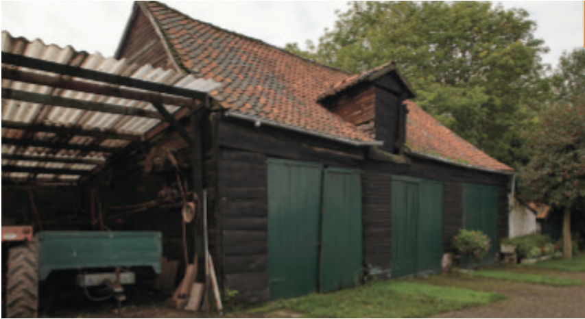
Het houten wagenhuis van de hoeve Royenberg in Merksem.
